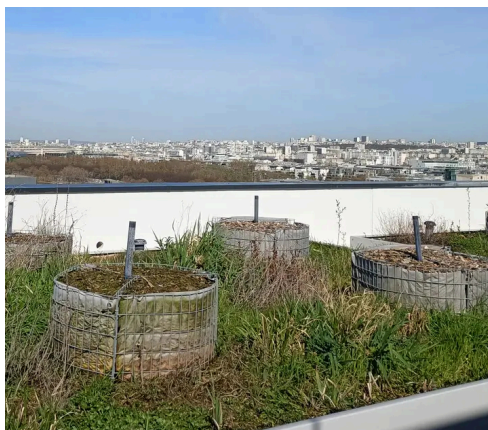
Exemple d'une installation en toiture à Saint-Denis
